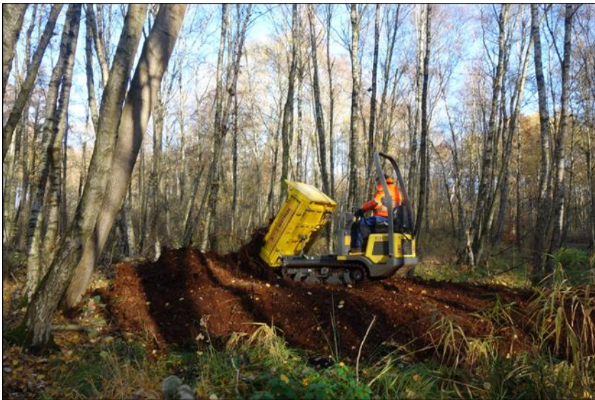
Abb. 3: Abladen des Bodenmaterials an der Einbaustelle vom Verschluss M3-1
